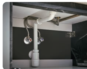
升級隱藏式排水管
