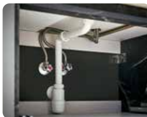
升級隱藏式排水管
